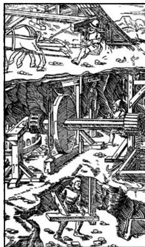
Рис. 7. Німеччина. Шахтний підйомальний механізм (за Г.Агріколою, 1556 р.)
