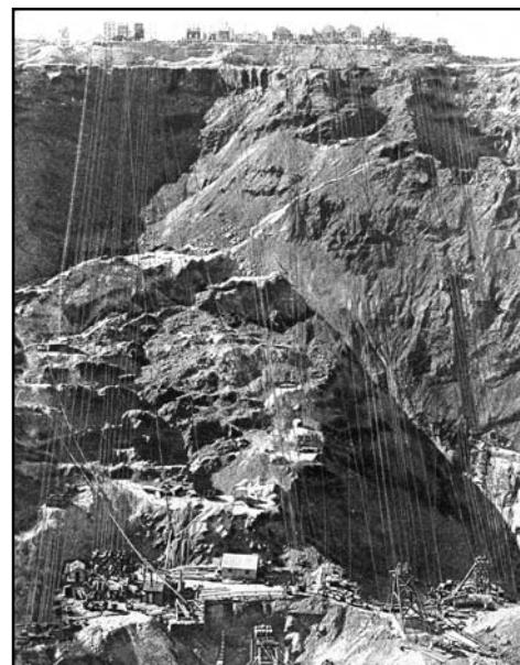
*Рис. 2. ПАР. Котлованна розробка кімберлітової трубки (фото 1880 р.)*
