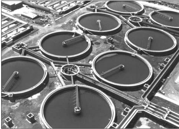
Система очистки промышленных стоков.
