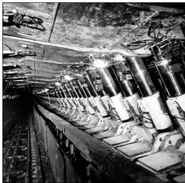
Привибійний (очисний) простір лави.
