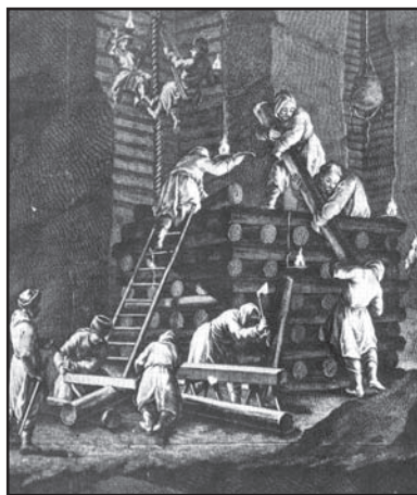
Спорудження дерев'яного костра (за Я. Борляхом, 1719 р.). Сучасний вигляд кострів (клітей)
