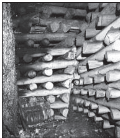
Спорудження дерев'яного костра (за Я. Борляхом, 1719 р.). Сучасний вигляд кострів (клітей)
