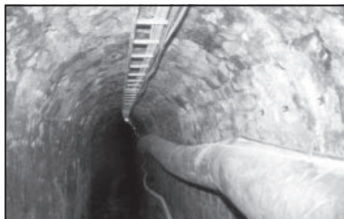
Ділянка з мурованим кріпленням (споруджена у 1806 р.)
