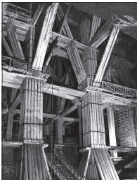
Дерев'яне кріплення в камері «Михаловіце»
