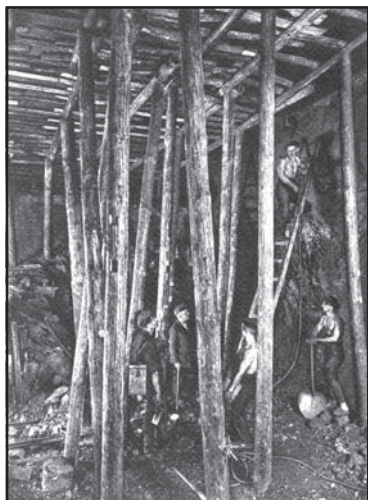
Стадія відбійки вугілля на пласті великої потужності при стовпній системі розробки (Катовіце, початок ХХ ст.)
