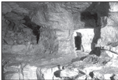
Цілики з вапняку для підтримання виробок
