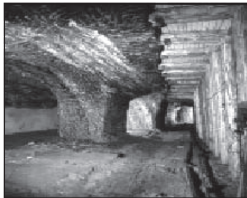
Підірні цілики та дерев'яні стояки
