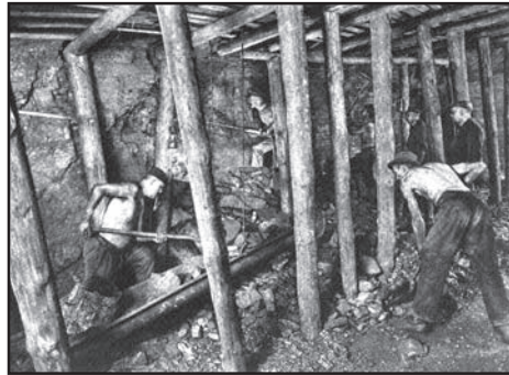
Роботи при стовпній системі розробки з підвішеними жолобами (Катовіце, початок XX ст.)
