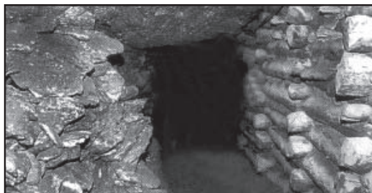
Підтримання виробленого простору за допомогою сухої закладки (зліва) та дерев'яних кострів
