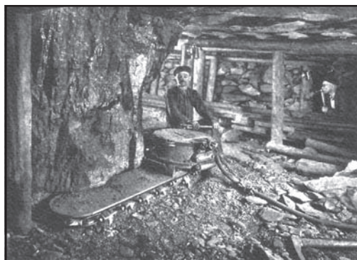
Створення врубу в підшві вугільного пласта з використанням ланцюгової врубової машини (Катовіце, початок ХХ ст.)
